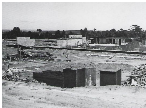
Construção do novo Hospital Veterinário - 1974
